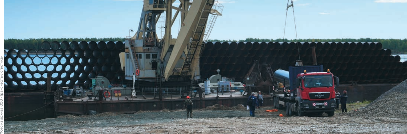
Перевалка труб на автомобильный транспорт с временной площадки хранения на барже
